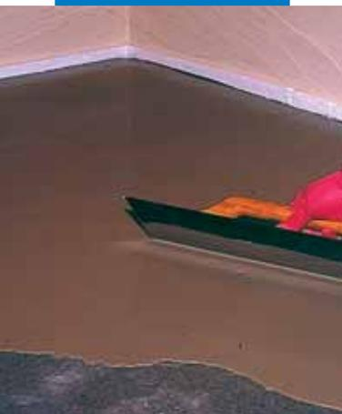
Нанесение **Novoplan 21** металлическим шпателем на цементную стяжку поверх грунтовки **Primer G**
